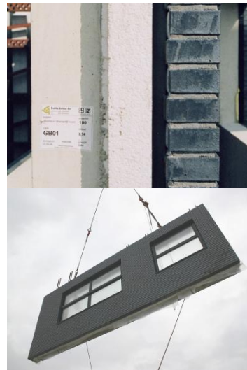
Dubbelschalig gevelelement met luchtspouw
