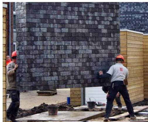
Enkelschalig gelijmd element voor prefab berging
