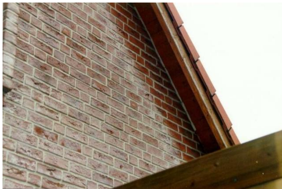
Scherpe begrenzing tussen het beregende en met zon beschonen gedeelte en het droge deel van de gevel
