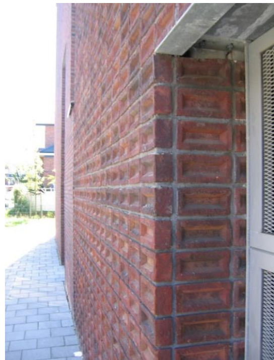
Aanzicht van in tegelverband uitgevoerd metselwerk voorzien van lintvoegwapening
