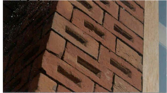
Klamp gelijmd metselwerk
